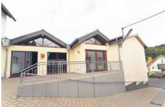
Gemeindehaus in Oberelz
