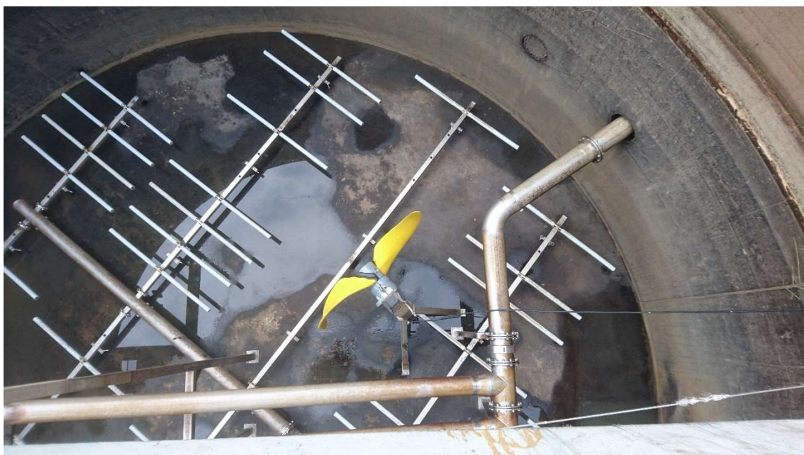
Abb. 8: Schlauchbelüfter bei Installation und Rührwerk SBR-Behälter
